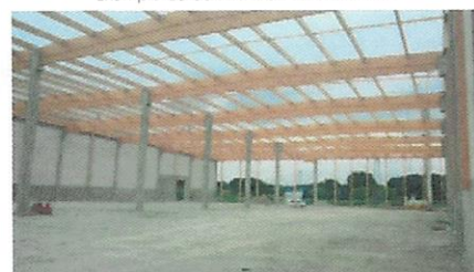
Exemple de bâtiment en structure bois partielle
