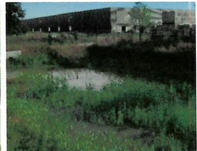
Ouvrage de gestion des eaux pluviales
