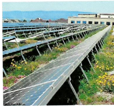
3 et 4. Toitures "bio-solaires"
