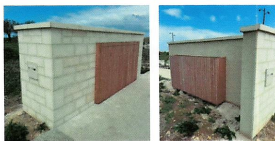
Photographie des murets en place réalisés par l'aménageur
