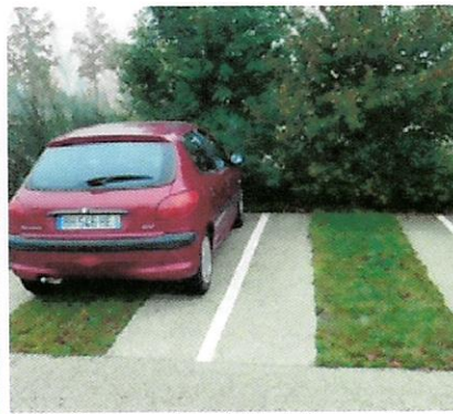
Surfaces semi-perméables stationnements
