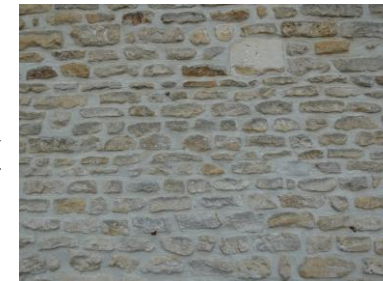
Exemples de matériaux traditionnels à privilégier (Geostudio)
