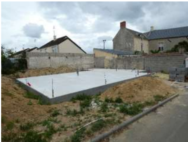
Maison en construction sur la commune Langrune-sur-Mer en 2022 (Source : Géostudio)
