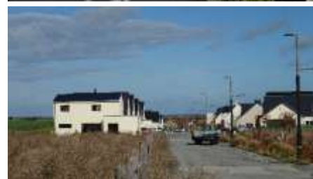
Zone commerciale (en h.) et nouveau quartier d'habitat en construction (en b.) à Douvres-la-Délivrande (Source : Géostudio)
