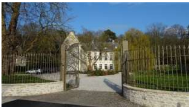
Maison de Maitre à Reviers
