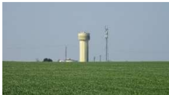
Antenne relais 4G à Colomby-Anguerny (Source : Géostudio)
