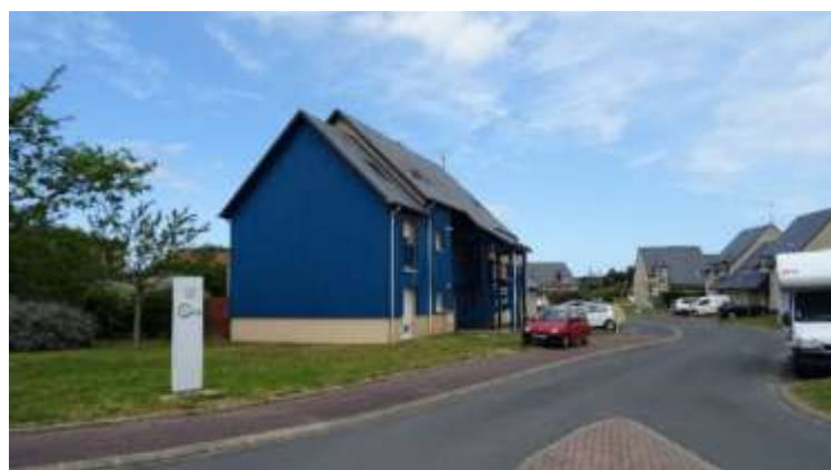
Habitat collectif avec escalier en extérieur, toit à deux pans et alternance des matériaux avec tuiles, agglos et bois peints en bleu à Saint-Aubin-sur-Mer
