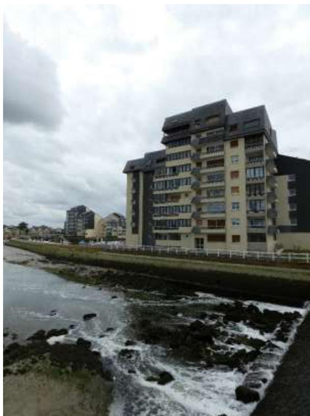
Logement collectif au bord de l'estuaire de la Seulles, à Courseulles-sur-Mer (Source : Géostudio)
