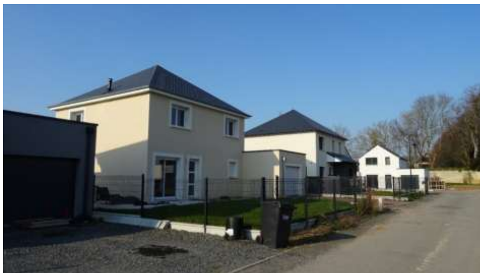
Des logements pavillonnaires sur Anisy (Source : Géostudio)
