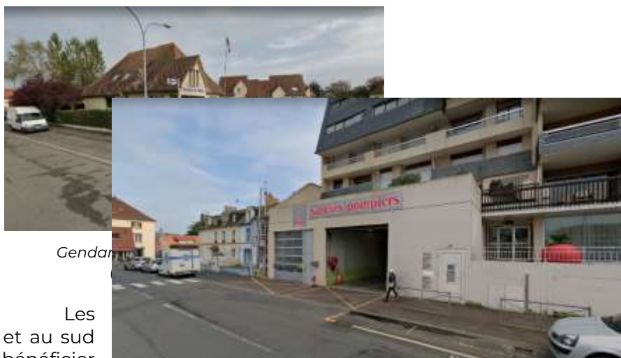
Caserne de pompier à Courseulles-sur-Mer (Source : Google Maps)
