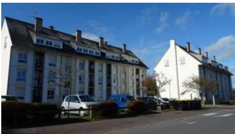
Habitat collectif ancien avec façade linéaire et aspect extérieur ancien et déconnecté de l'espace public à Courseulles-sur-Mer (Source : Géostudio)
