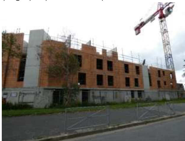
Logements collectifs en construction à Courseulles-sur-Mer en 2022 (Source : Géostudio)
