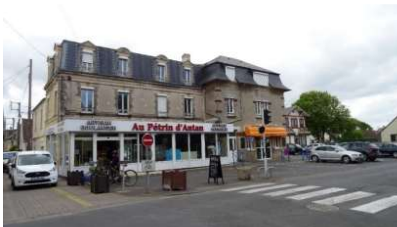
Boulangerie de Langrune-sur-Mer (Géostudio)
