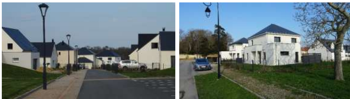
Des opérations récentes de construction d'habitat sur les communes de Reviers (à g.) et Anisy (à d.) (Source : Géostudio)
