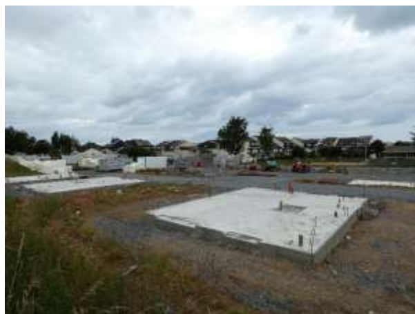
Des petits logements en construction à l'entrée de Courseulles-sur-Mer en 2022 (Source : Géostudio)
