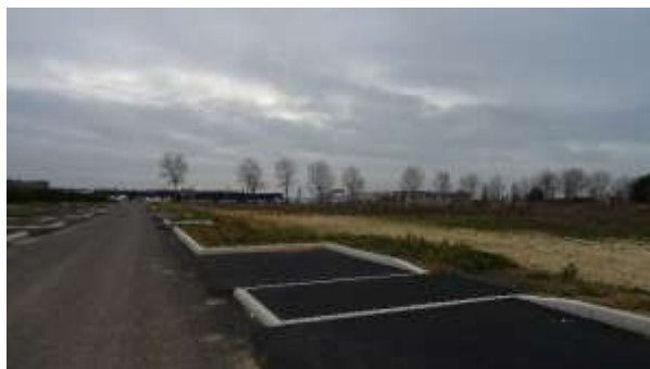
Futures places de stationnement dans la ZAC St-Ursin à Courseulles-sur-Mer (Source : Géostudio)
