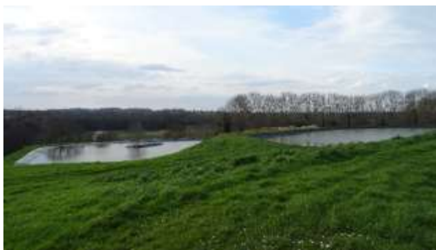
Le lagunage de Reviers qui surplombe la vallée de la Seulles à l'arrière-plan (source : Géostudio)
