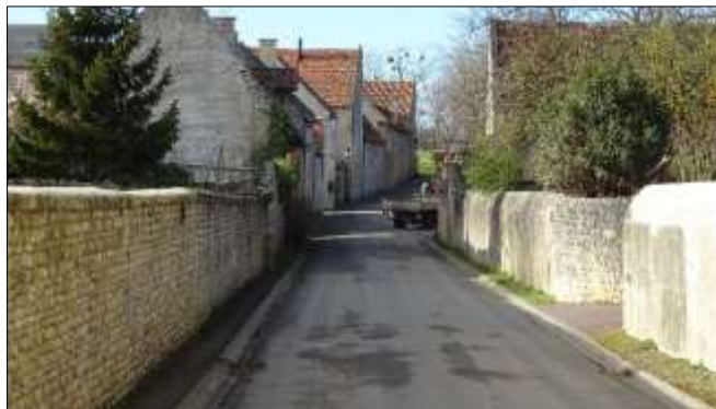
Front bâti composé de constructions et de murs de clôtures en pierre de Caen dans le centre-bourg de Plumetot
