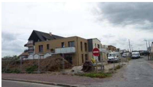
Des appartements en petit collectif en construction à Langrune-sur-Mer en 2022 (Source : Géostudio)
