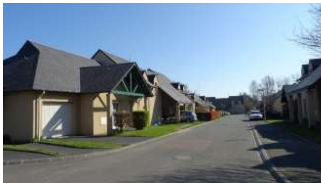
Zone d'habitats individuels groupés à Cresserons (Source : Géostudio)
