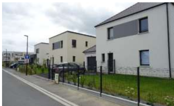
Des maisons individuelles récentes à Langrune-sur-Mer (Source : Géostudio)
