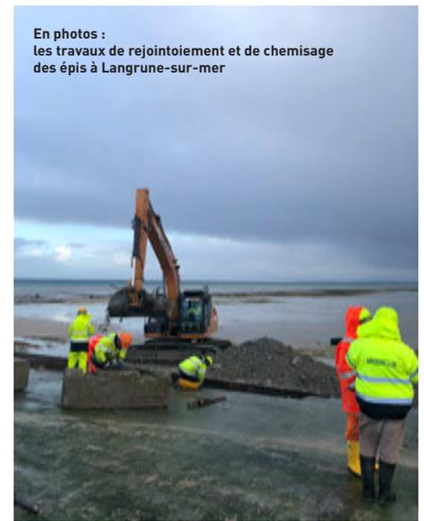
En photos : les travaux de rejointoiement et de chemisage des épis à Langrune-sur-mer
